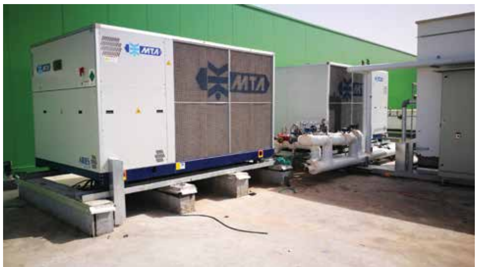
שני צ'ילרים MTA בתפוקה של 50 ט"ק כל אחד במפעל בדרום. מתוכנן: משרד AES - מהנדס עמוס חלפון, קבלן מבצע: צ.ג.ג.
