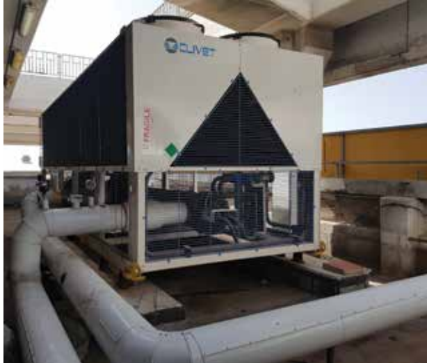
צ'ילר Clivet, 200 טון קירור למיזוג אוויר ברשת סופר מרקטים, קבלן מבצע: א.צ. אקלים ליין
